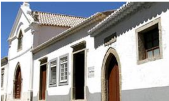
Fachada Principal da Capela e Albergaria
